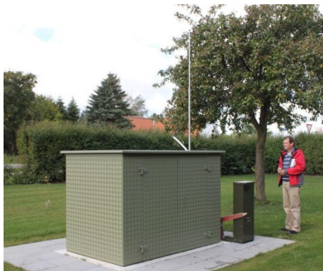
En nyere boring. Selve boringen er inde under huset. Bemærk radioantennen på taget.
